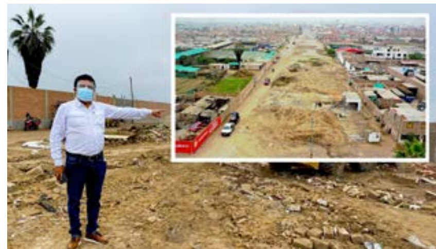
Alcalde de Víctor Larco, Lic. César Juárez, muestra los trabajos de ampliación de la Av. Juan Pablo II con evitamiento.
