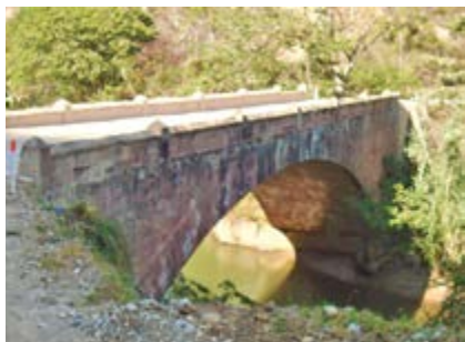
Puente de Burgos, sobre el río Utcubamba.
