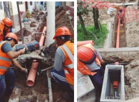
Trabajadores de Sedalib, cambiando las tuberías.
